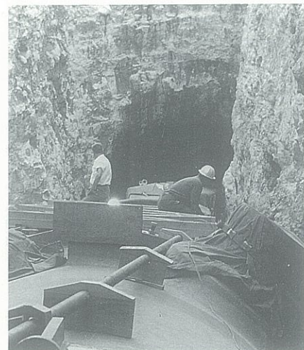
Vasija del reactor a la entrada de un túnel. Agosto 1966
