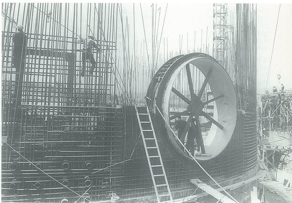
Exclusa permanente de acceso al edificio de contención. Mayo 1966
