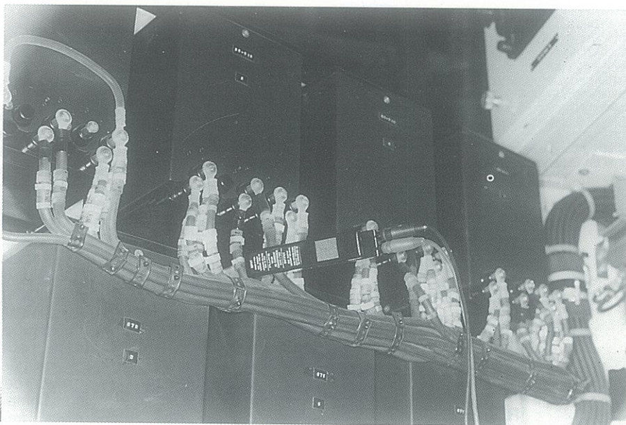
Detalle de la disposición de la sonda de corriente en un circuito secundario de protección.
