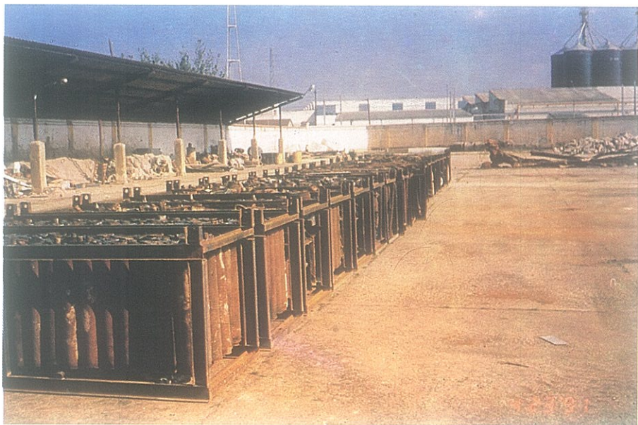
Almacenamiento temporal de jaulas.
