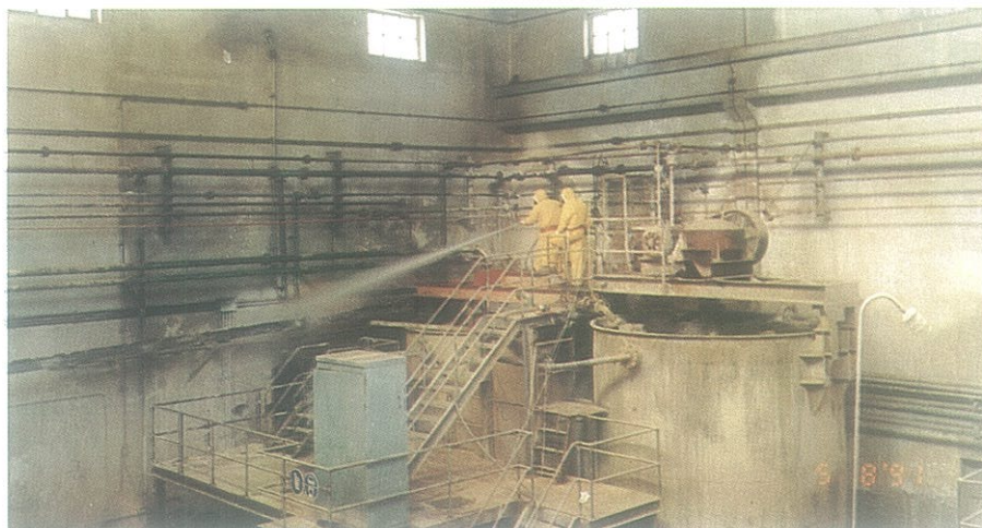
Limpieza de equipos en edificio de proceso químico.
