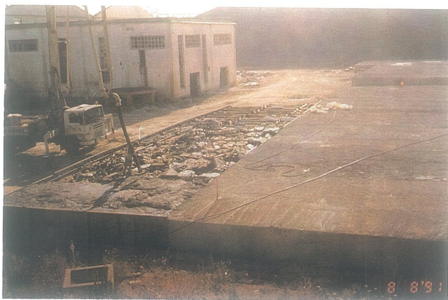
Hormigonado de productos de dismantelamiento.
