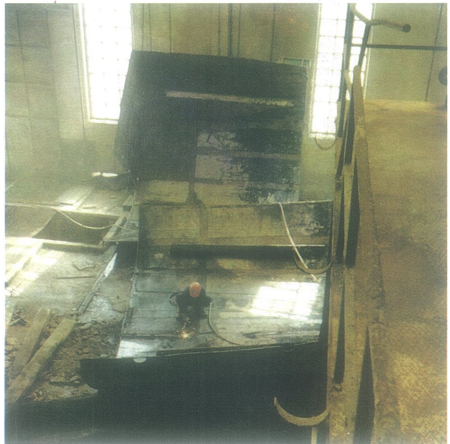
Corte de tanques.
