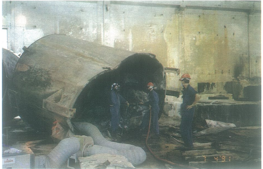
Descosado de tanques.
