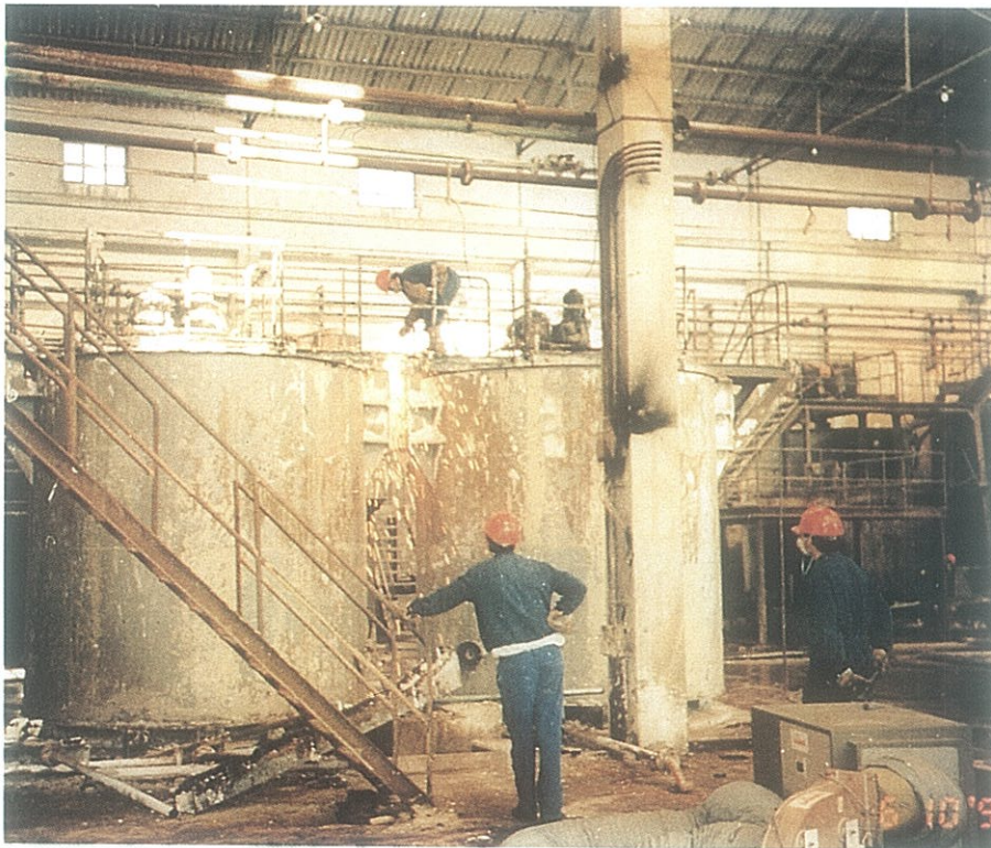
Trabajos de desmantelamiento en la FUA.
