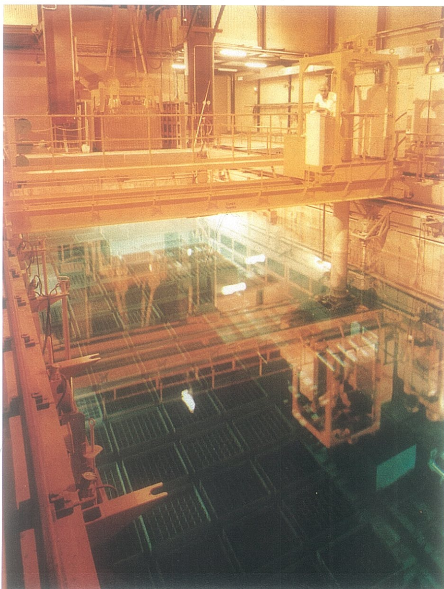
Piscina de almacenamiento de combustible gastado de Vandellós I.
