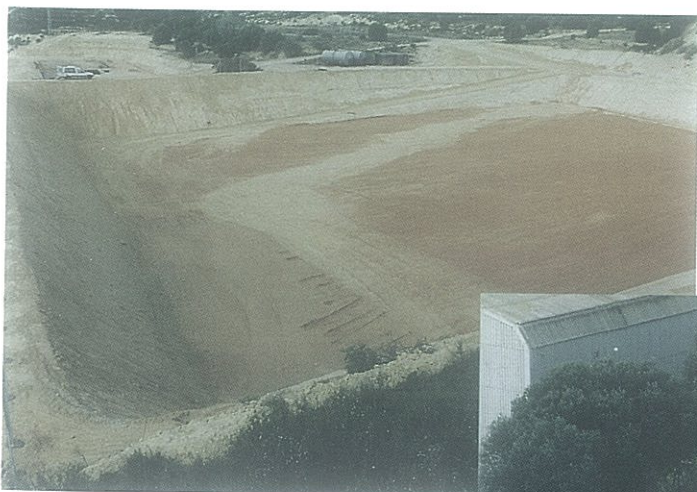
Estado actual de construcción de la balsa de Lixiviados.
