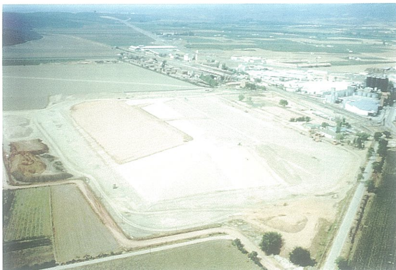
Vista de la FUA con la fábrica desmantelada, los diques remodelados y casi finalizando las capas de cobertura.
