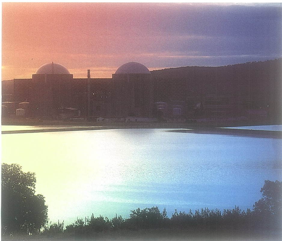
Vista general de la central.
