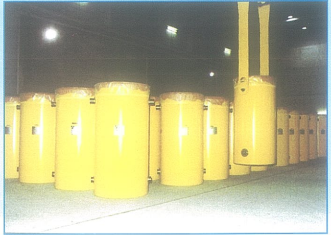
F II. A la izquierda, vista de la instalación de almacenamiento de la central estadounidense de Surry, Virginia, con contenedores metálicos tipo CASTOR y NAC. A la derecha, vista del interior de la instalación de Ahaus (Alemania)
