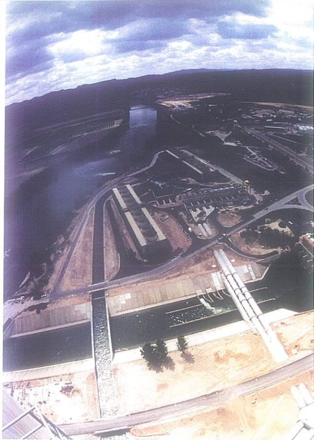
Panorámica del Sistema de refrigeración
