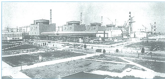
Vista general de la Central Nuclear de Zaporozhe en Ucrania
