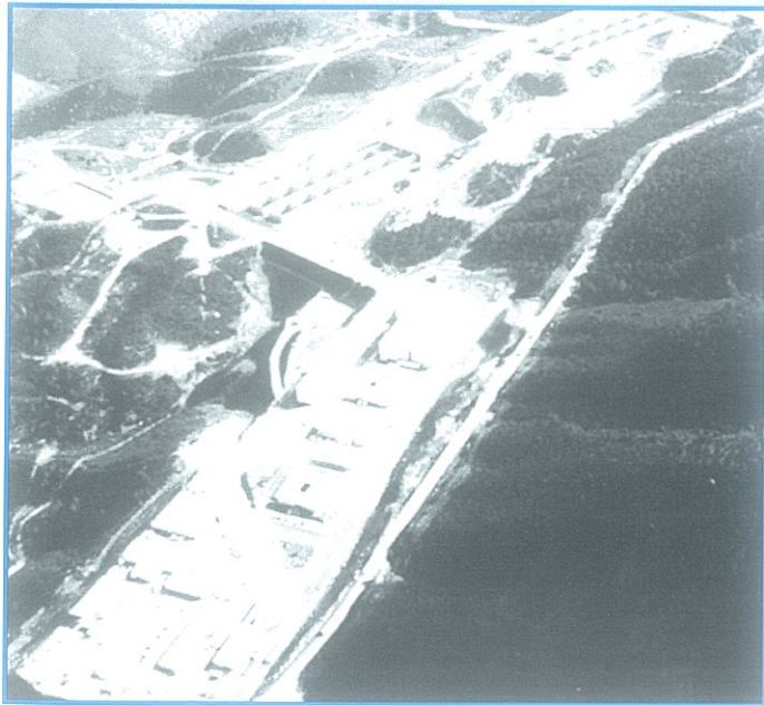
Almacén de Residuos de "El Cabril"
