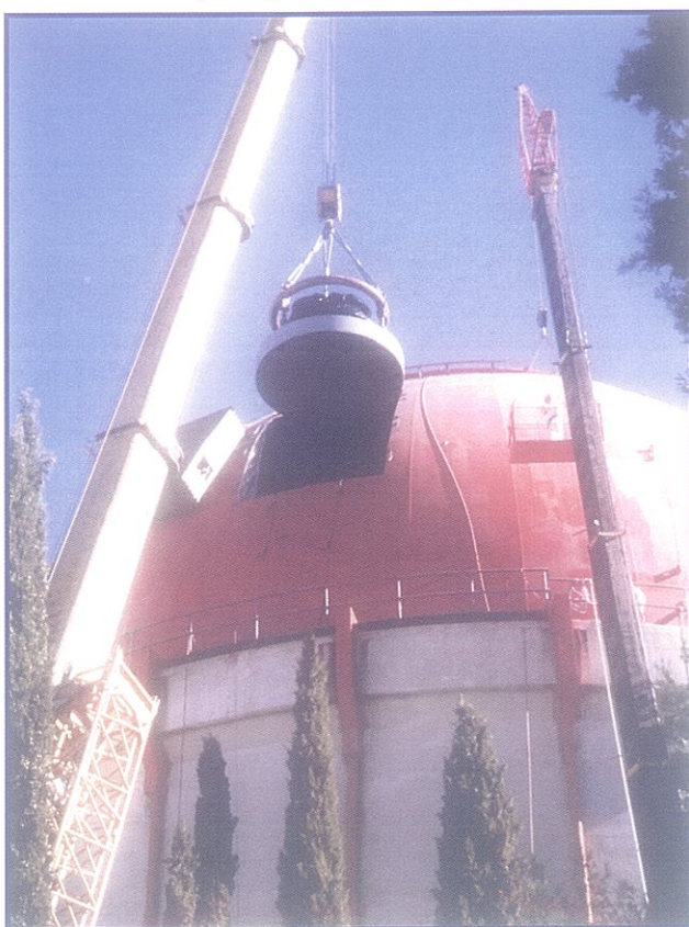
F III - Extracción Tapa antigua.
