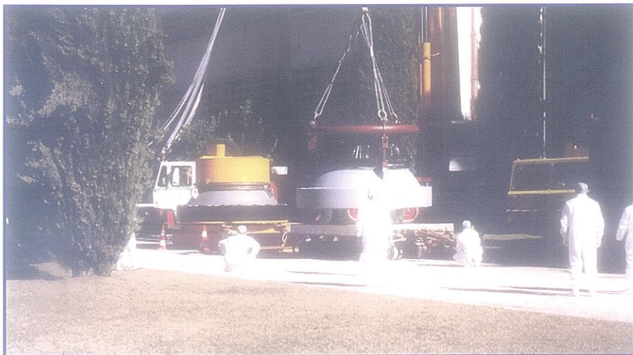
F II - Tapas nueva y original en el exterior del recinto.
