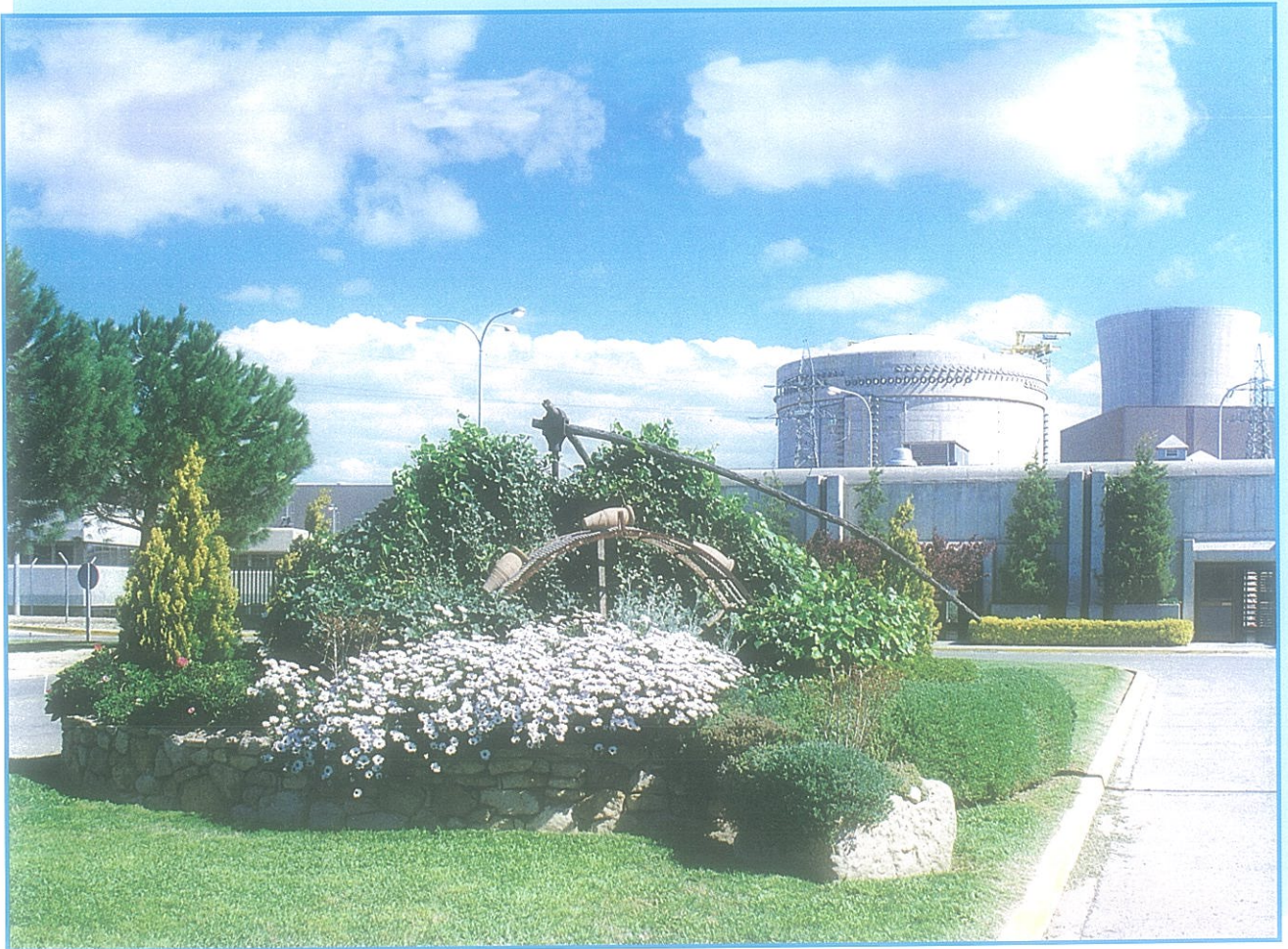
Vista de la Central Nuclear de Ascó
