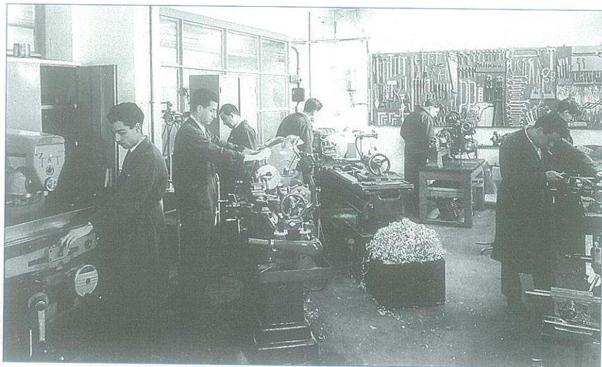
Taller mecánico del reactor JEN I
