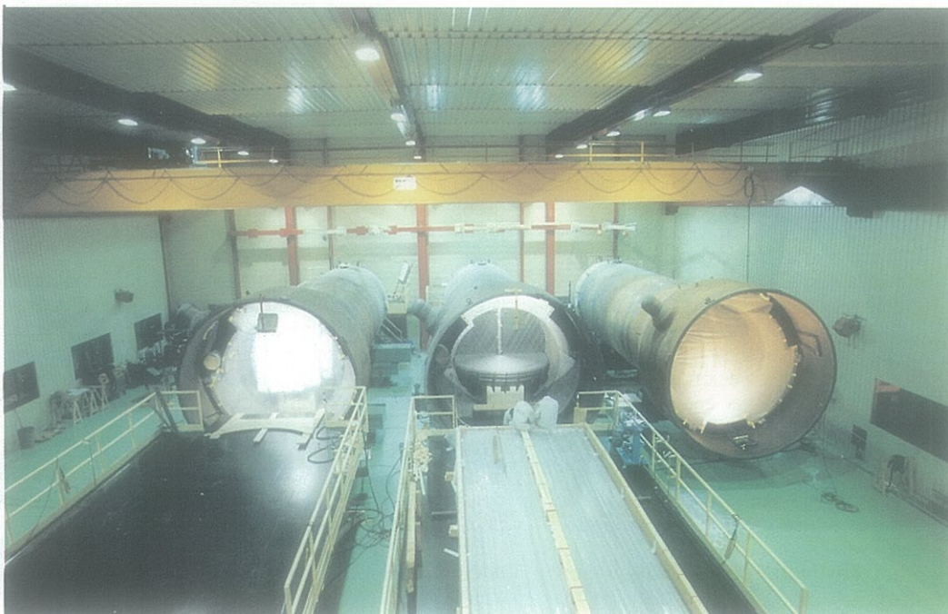
Entubado de Generadores de Vapor en Área limpia
