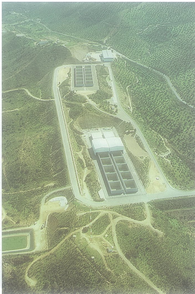
Vista de la instalación de almacenamiento de residuos de baja y media actividad de El Cabril.
