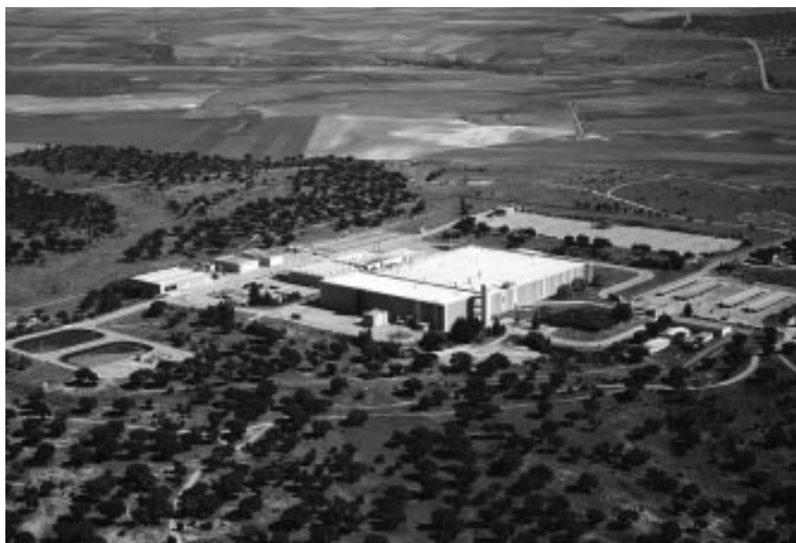
Fábrica de Elementos Combustibles Nucleares de ENUSA en Juzbado (Salamanca).
