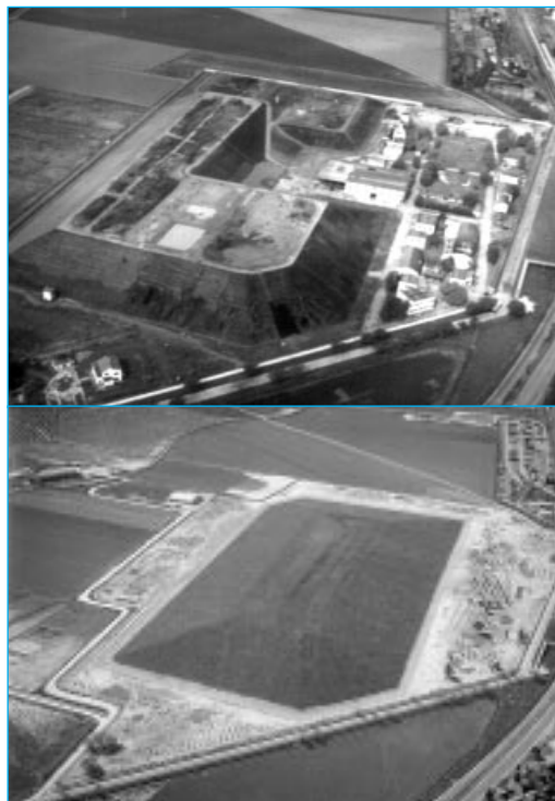
Fábrica de uranio de Andújar antes y después de su restauración.
