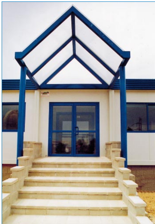
Entrada a las nuevas oficinas de servicios de Ingeniería de Apoyo Initec.
