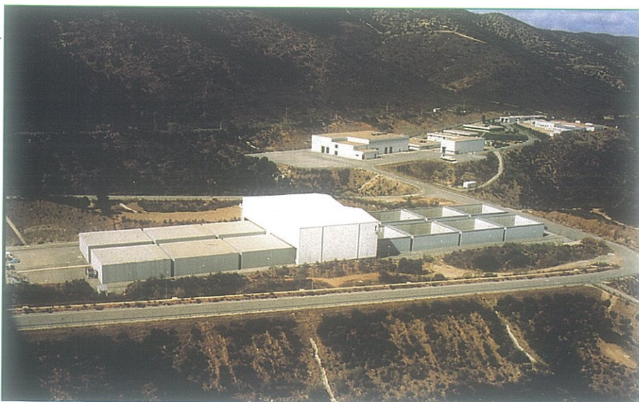
Vista aérea de la plataforma norte e instalaciones.
