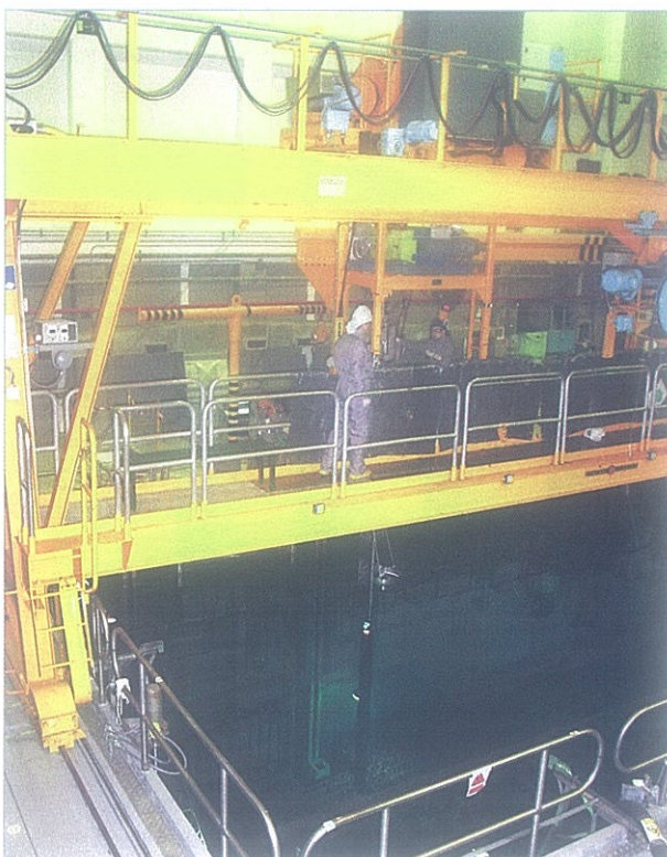
Piscina de almacenamiento de combustible gastado, durante la recarga.
