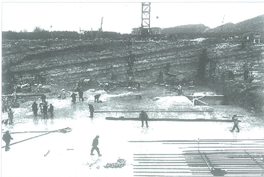
Construcción de la central. Edificio del reactor 1967.
