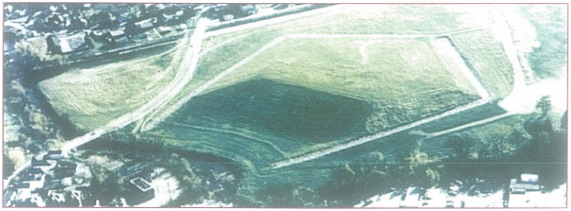
Restauración medioambiental de antiguas instalaciones asociadas a la minería del uranio. (Canonsburg, USA).
