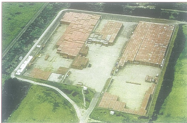
Vista aérea del almacenamiento de RBA, Drigg (BNFL, R.U.).
