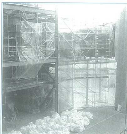
Trabajos de desamiantado en conducto de salida de humos a chimenea común Grupos I y II.
