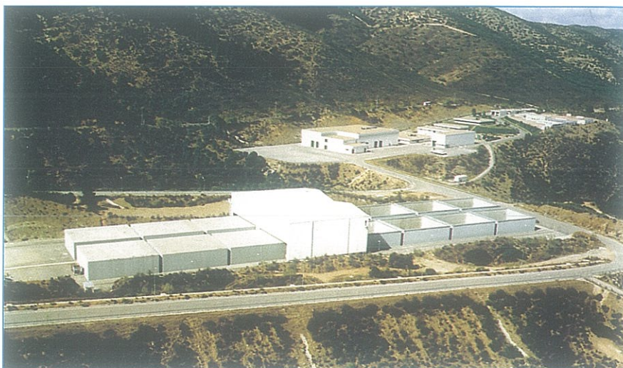
Vista aérea de la plataforma norte e instalaciones de El Cabril.
