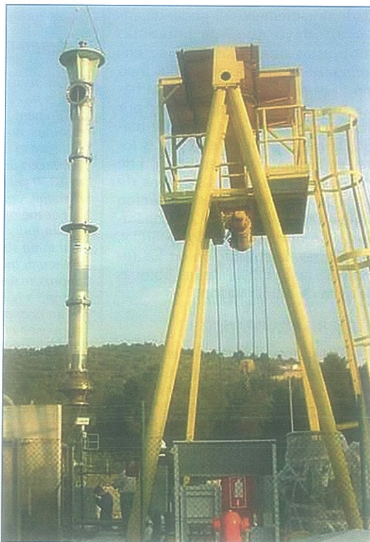
Maniobra de instalación de una de las nuevas bombas de Agua de Servicios Esenciales/Installation maneuver of one of the new Essential Service Water pumps.
