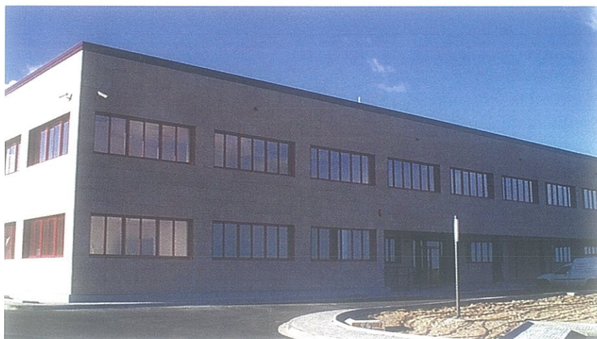
Edificio Sede de Tecnatom en Cataluña.
