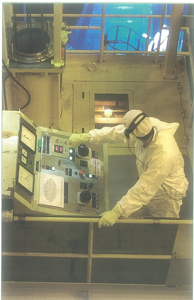
Grúa de recarga de combustible.
