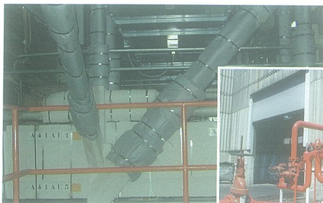
PROTECCION DE BANDEJAS
