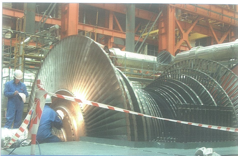
Cambio de turbina en Vandellós II.
