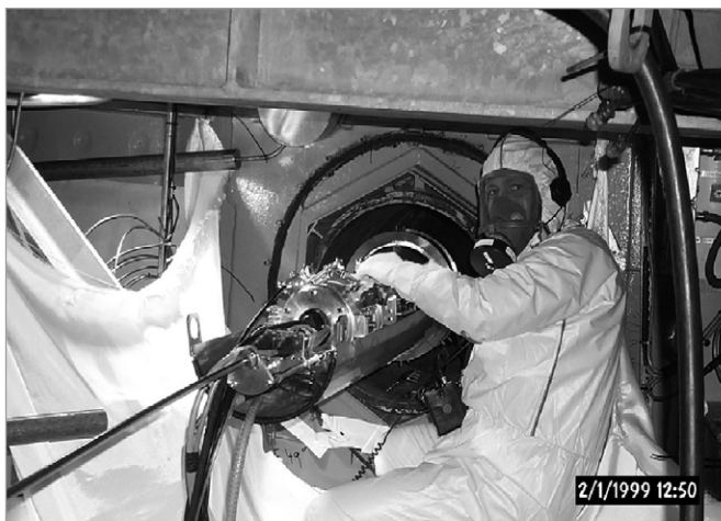
Figura 9. Inserción de un Manipulador en Tubería para reparación inserto de soldadura BWR.
