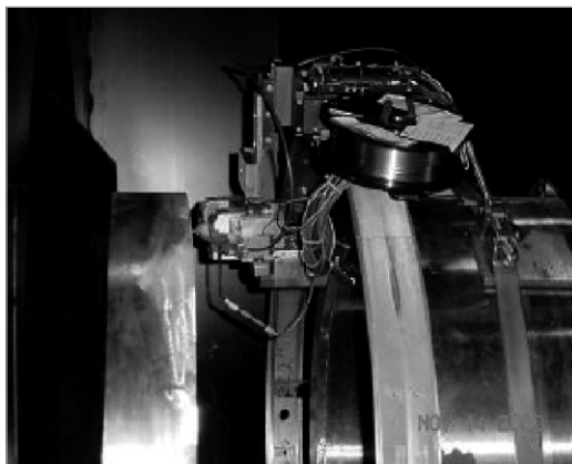
Figura 14. Soldadura nuevo depósito.
