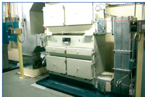
Filtro secundario de efluentes radiactivos gaseosos.
