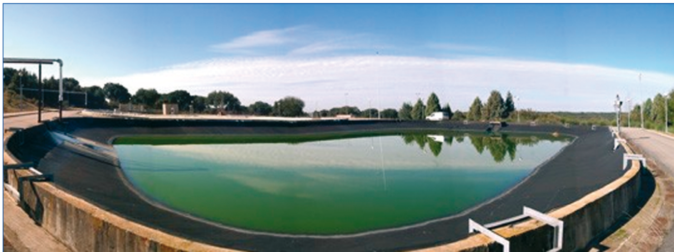
Laguna de regulación de efluentes radiactivos líquidos.
