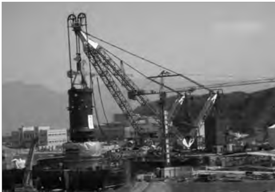
Figura 1. Instalación de la Vasija de Presión del Reactor en la Unidad nº 1 de la central de Lungmen en Taiwan (Marzo de 2005).
