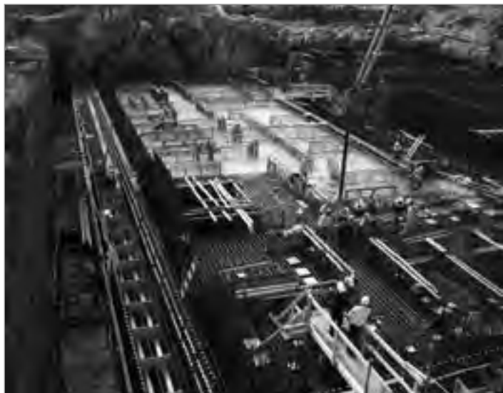
Figura 2. EPR - El hormigón de las fundaciones se cuela en Olkiluoto.
