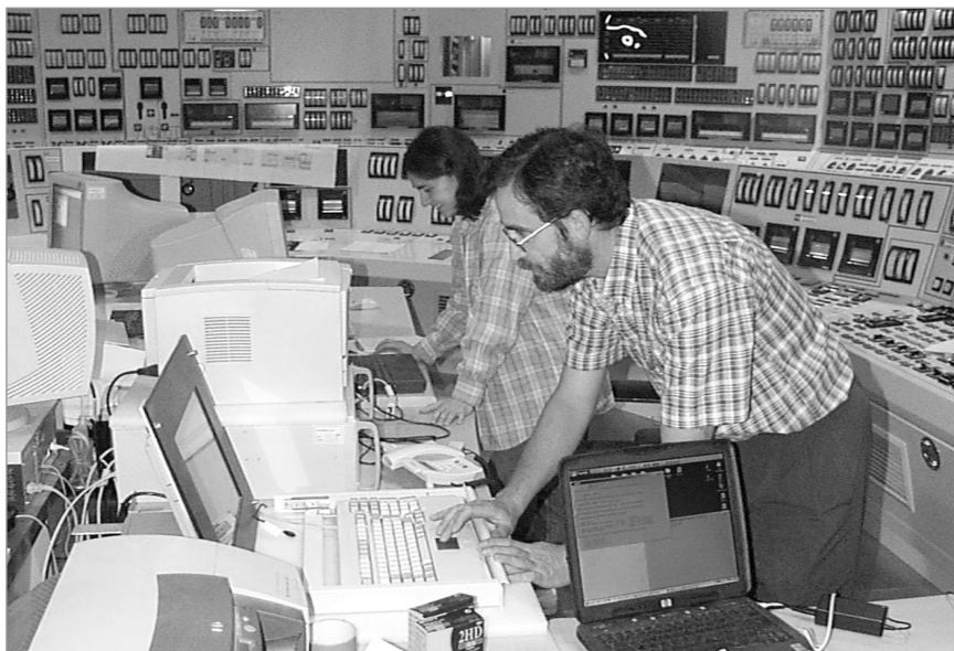
Figura 1. Uso del simulador para ajuste de lazos de control e instrumentación.
