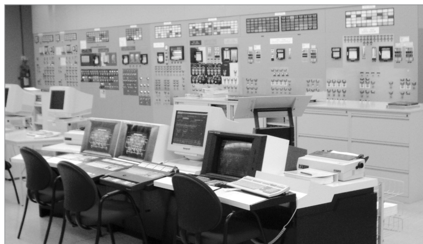
Figura 14. Sistema de control distribuido. Simulador CN Cofrentes.
