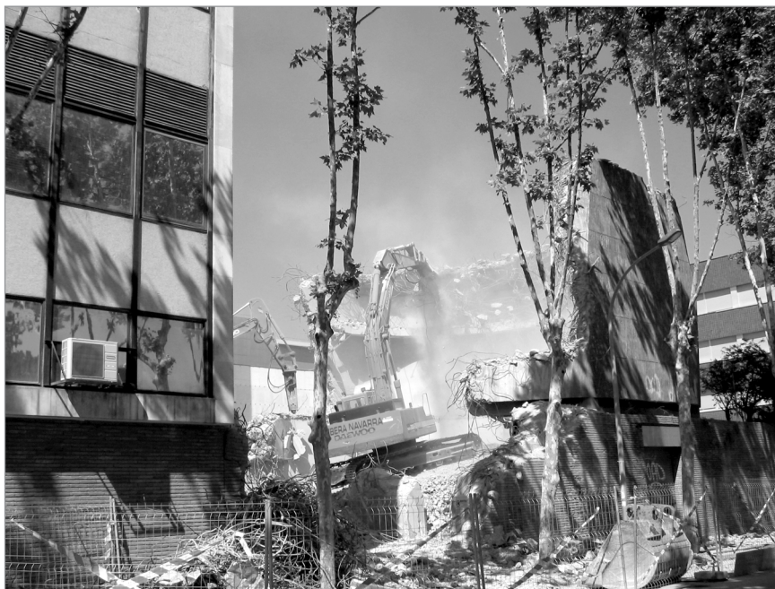
Figura 3. Demolición del edificio de contención (agosto 2005).
