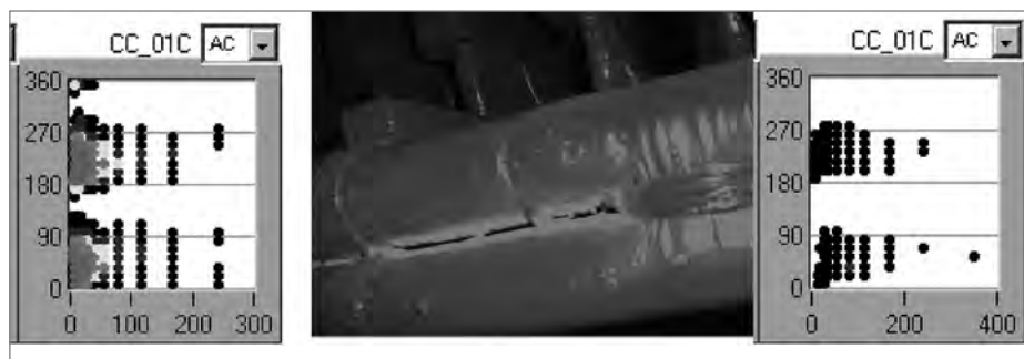
Figura 10: Descargas parciales en el anillo entre las fase A y C
