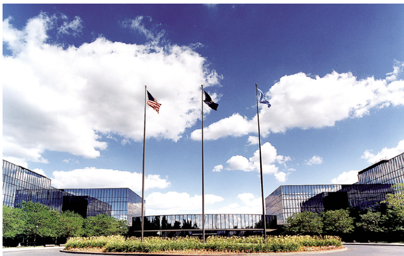
Centro de energía de Westinghouse. / Westinghouse Energy Center.
