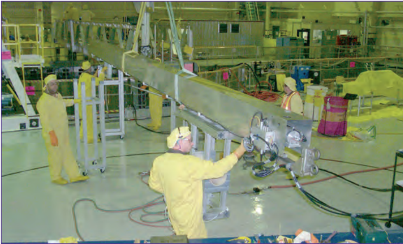
Equipo TJET de inspección de bombas de chorro, listo para comenzar la inspección en una central americana.
