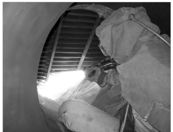
Figura 4. Trabajos de metalización en el interior del cross under.
