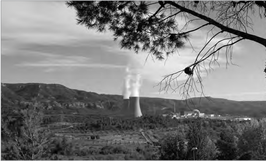
Figura 1. Central nuclear de Cofrentes.
