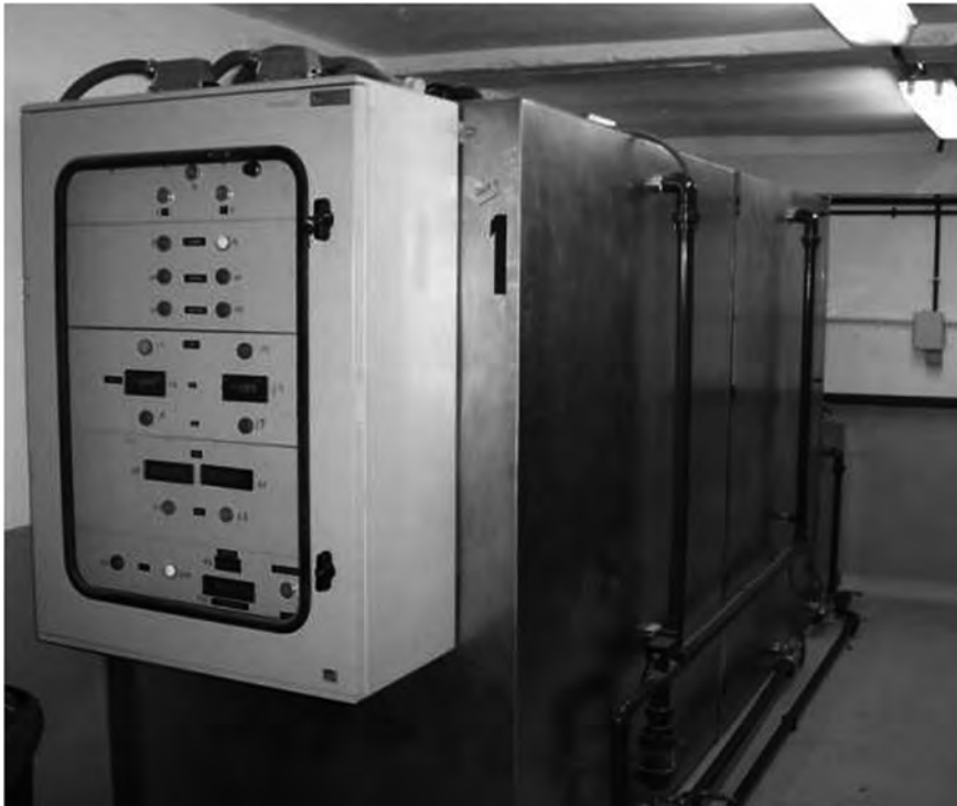
Figura 10. Depósitos para almacenamiento de residuos líquidos. Medicina nuclear.
