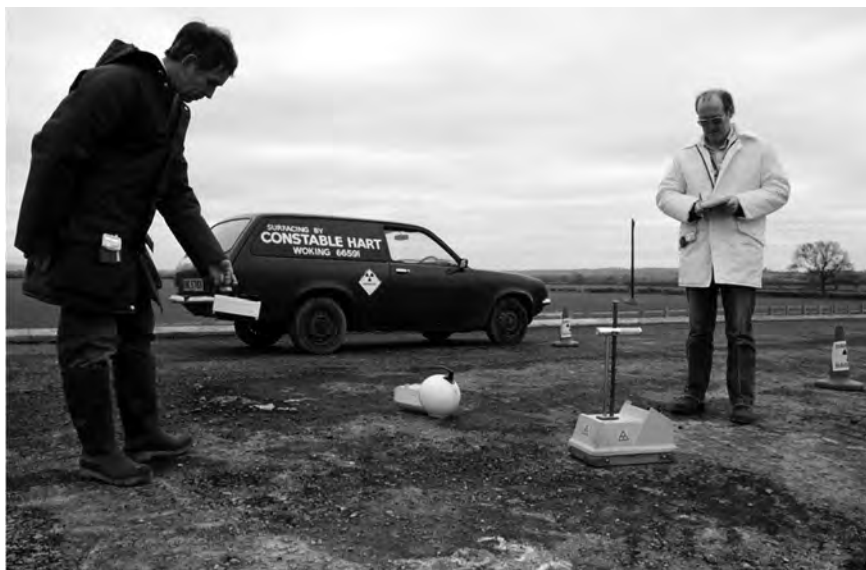
Figura 13. Medida de densidad y humedad de suelos. Operación en campo.
