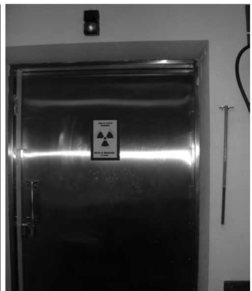
Figura 3. Puerta del búnker unidad de telecobaltoterapia.
