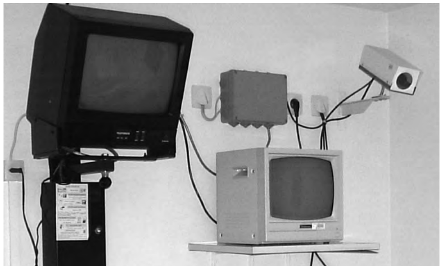
Figura 2. Control circuito TV en el interior de una habitación blindada.
