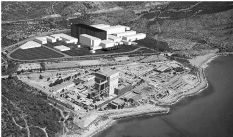
Central nuclear de Vandellós I.
