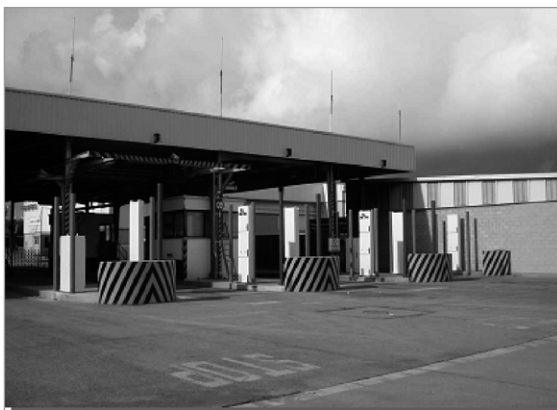
Figura 2. Instalación de pórticos en una terminal de contenedores.
