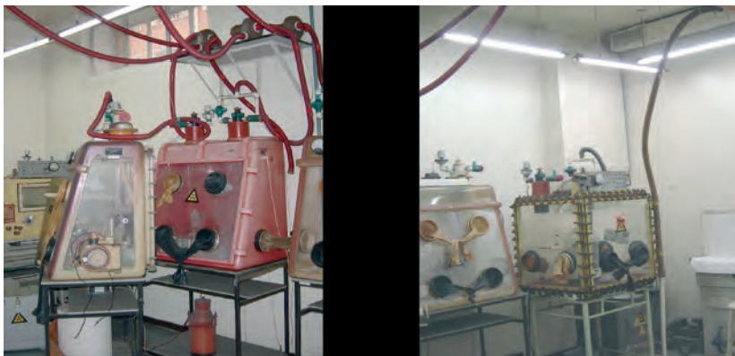
Figura 7. Cajas de guantes de IR-13A antes del desmantelamiento.
