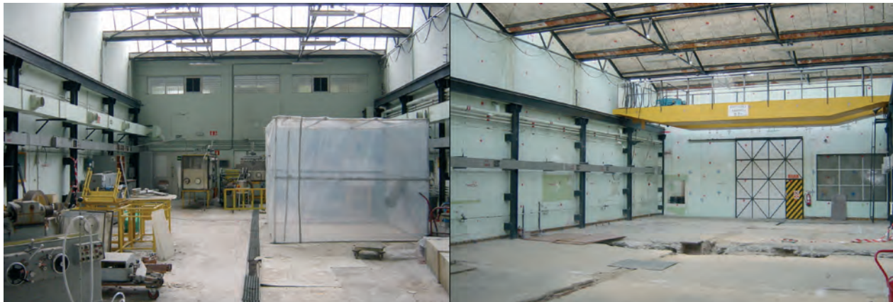
Figura 6. Planta IN-03 durante y después del dismantlamiento.
