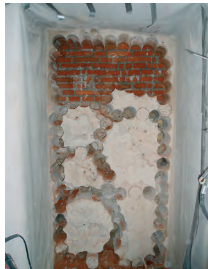
Figura 4. Generación de la puerta de acceso al depósito enterrado desde el nuevo acceso construido al efecto.
