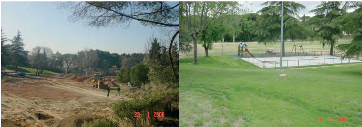
Figura 5. Panorámicas de la Zona Deportiva del CIEMAT durante y tras su rehabilitación.
