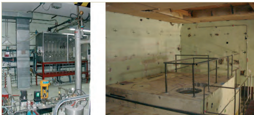
Figura 6. Techo de celdas antes y después.
