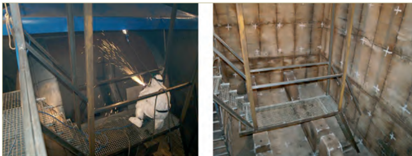
Figura 9. Corte de tanque y estado final de la unidad de intervención.
