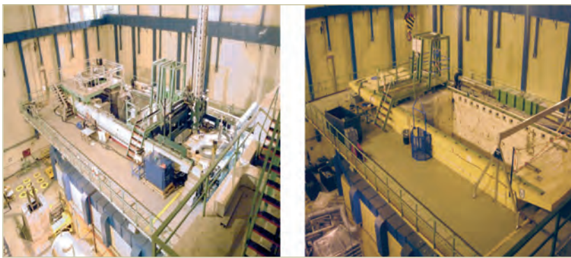
Figura 11. Desmontaje de componentes de la plataforma de la piscina.
