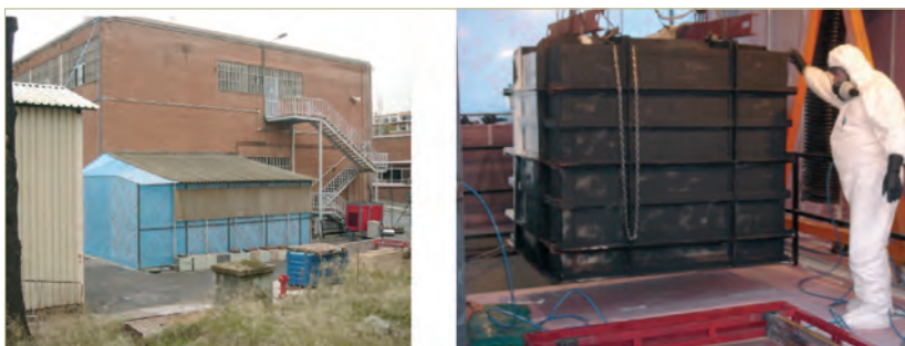
Figura 8. Extracción del tanque de residuos líquidos más activos de la fosa F1.
