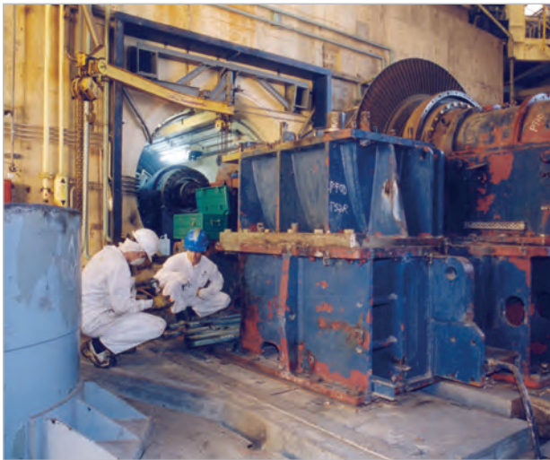
Figura 4. Desmantelamiento en nave del reactor. Desmontaje de una de los equipos turbosoplantes que refrigeraban el cajón del reactor.
