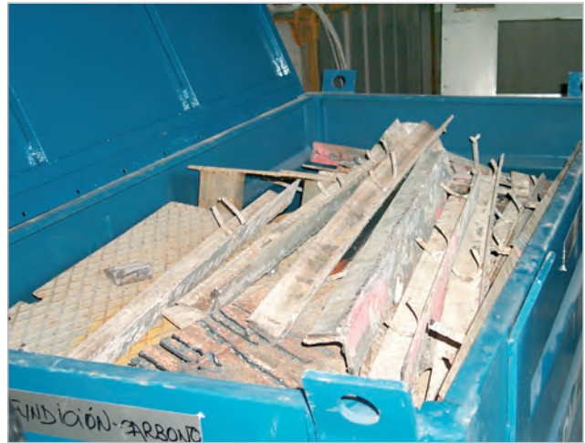
Figura 5. Residuos radiactivos de baja y media actividad procedentes del desmantelamiento de un edificio de residuos radiactivos. Estos residuos se alojaban en contenedores diferentes de los usados para materiales.
