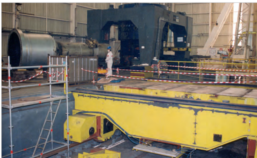
Figura 3. Desmantelamiento del Dispositivo Principal de Mantenimiento, equipo que recargaba "en caliente" (no hacía falta parar el reactor) el combustible del cajón del reactor.
