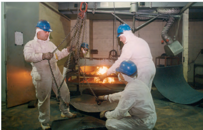
Figura 8. Taller de corte, ubicado en los sótanos de la nave del reactor. En él, se cortaban equipos, sistemas y estructuras previamente desmanteladas para poder alojar los materiales resultantes en contenedores.
