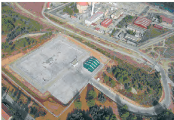
Figura 6. Ubicación de la Instalación de almacenamiento.
