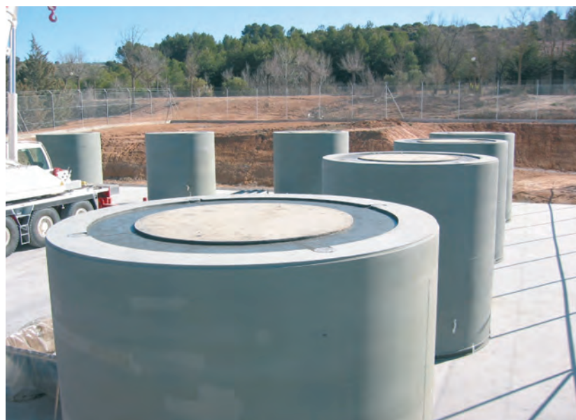
Figura 8. Módulos de almacenamiento hormigonados.
