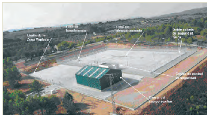
Figura 7. Componentes del ATI de la Central Nuclear José Cabrera.
