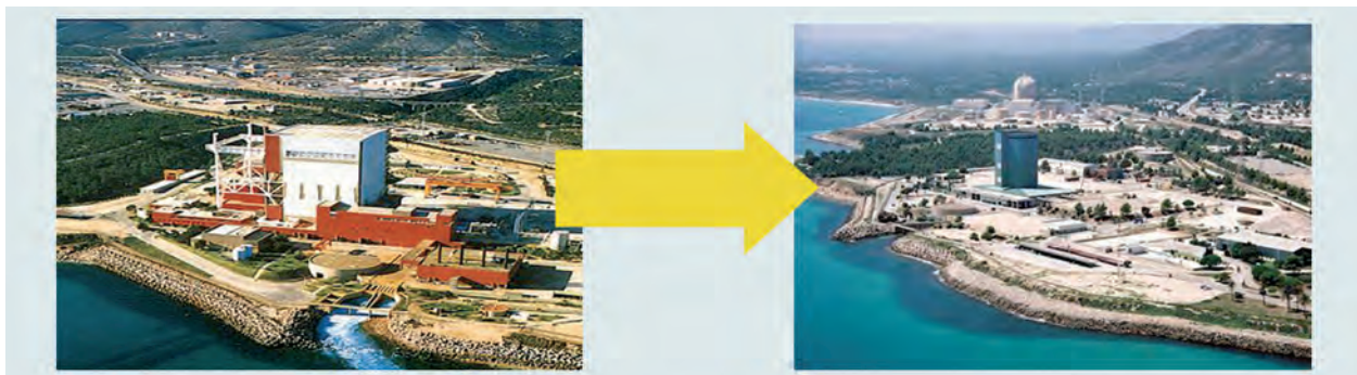
Figura 2. Vandellós I. Desmantelamiento nivel II.
